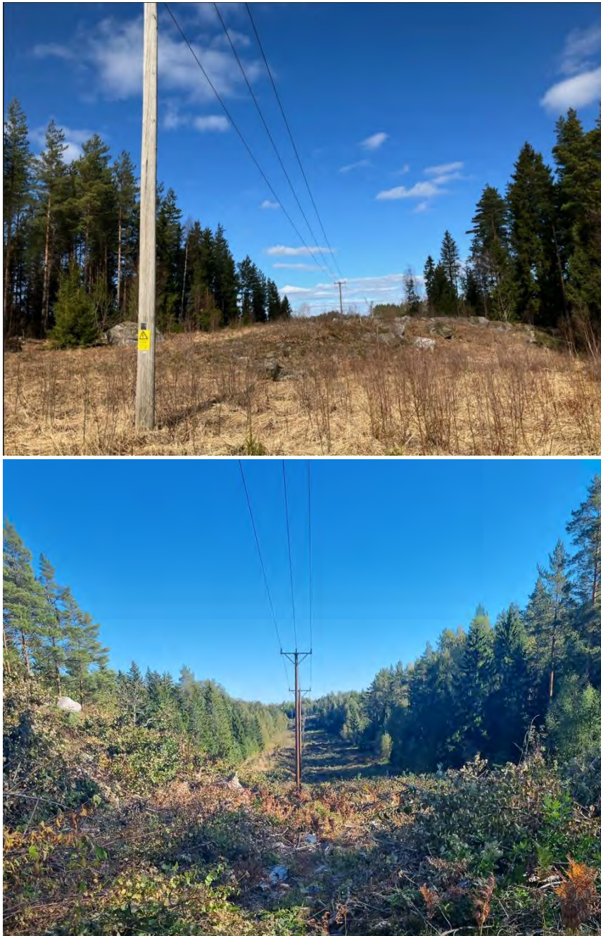
Figur 2 Två olika exempel på 20 kV-ledning (enkelstolpe) i trädsäker ledningsgata (regionnät)
