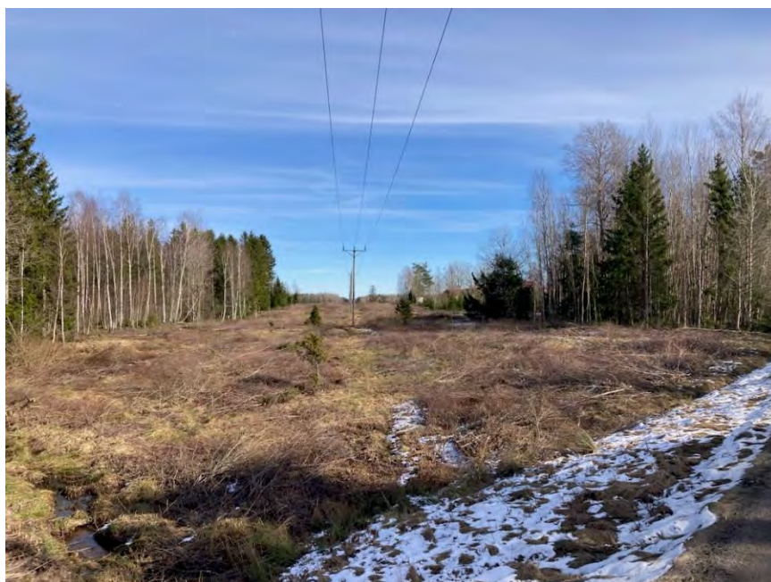
Figur 1 Exempel på 40 kV-ledning (enkelstolpe) i träsäker ledningsgata
